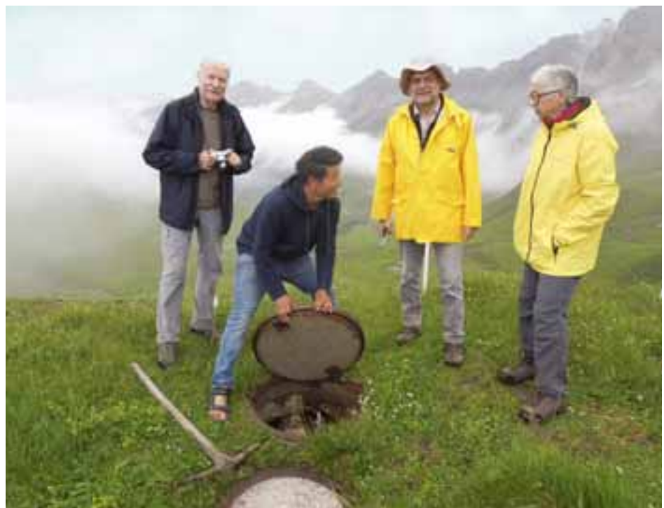
Inspektion der Kläranlage
